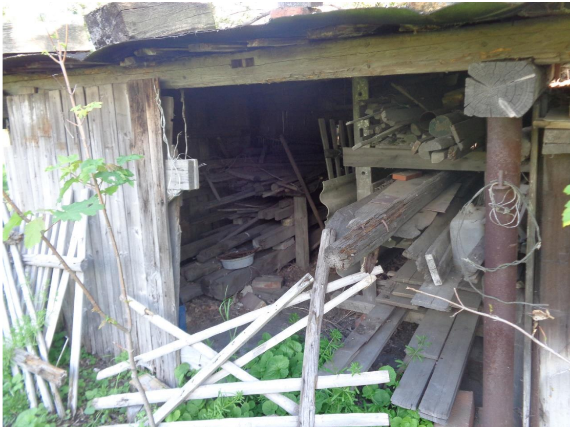
Abbildung 15: Schuppen im Nachbargrundstück
