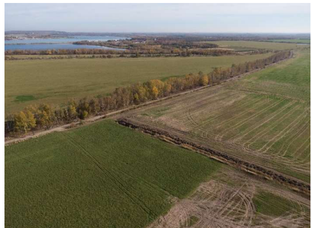
... und südliches Baufeld des Energieparkes
