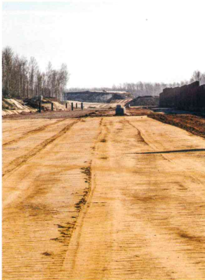
Blick von Norden auf die Trasse der A 72 (Richtungsfahrbahn Leipzig) mit der Anschlussstelle Zwenkau im Hintergrund
